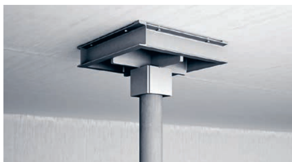
Erhöhter Durchstanzwiderstand: der Stahlpilz von RINO Exo
