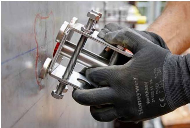
Einfachste Montage: Auf der sauberen Stahlschalung wird die genaue Position der Bewehrung angezeichnet.
