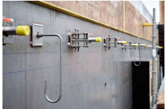
Dies garantiert einen festen Sitz der Bewehrung auch während des Betonierens.
