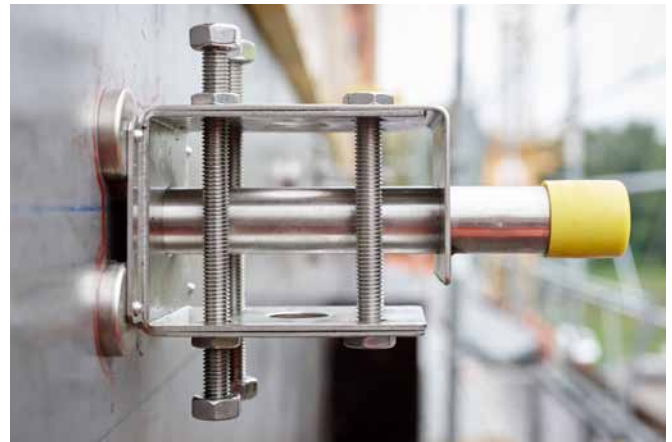
Die Magnete ziehen die Bewehrung mit 1,2 kN gegen die Schalung und fixieren sie. Es empfiehlt sich, die Hülse vor dem Betonieren zusätzlich mit einem Betonstahl in der Lage zu sichern.
